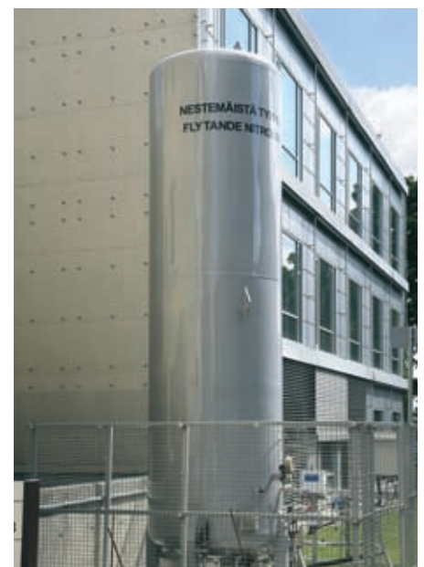
Tank med flytande kväve som färgsatts för att passa in i arkitekturen.
